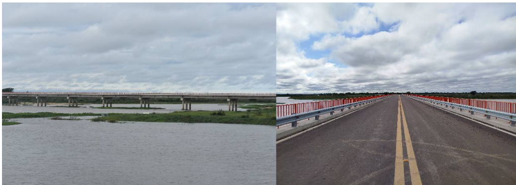
Figura N° 4. Puente Paraná– Mini/ Ruta Provincial N.º 32 (Tramo: RN N.º 11 – Puerto Ocampo)
