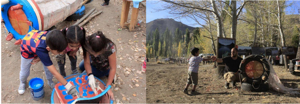
Figura N° 3: Construcción de la balsa en Villa Llanquín
