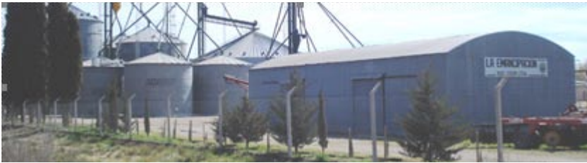
Figura N° 8. Planta de acopio La Emancipación
